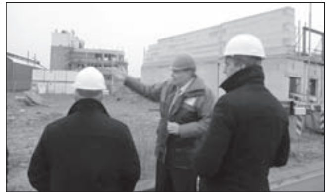
Klaas Stolk geeft uitleg over de voortgang van de bouw
