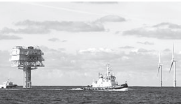
Het Offshore Windpark Q7 in de Noordzee
