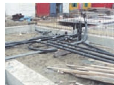
De leidingen in de kruipruimte
