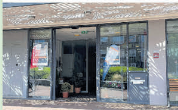
Sluis 751 • Lange Nieuwstraat 751
