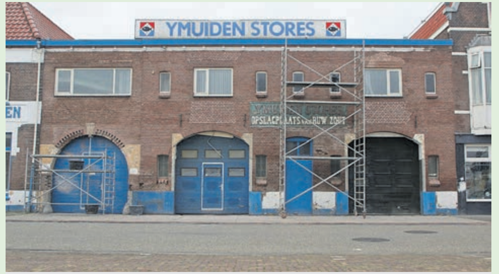
Na het verwijderen van de witte band tussen de begane grond en de eerste verdieping werd de gevelsteen zichtbaar. Hier is de steen nog deels verborgen achter de hoge steiger. Foto: Erik Baalbergen
