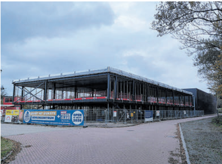
Aanzicht van het pand, dat in de komende weken wind- en waterdicht wordt gemaakt. Foto: Bison Bowling
