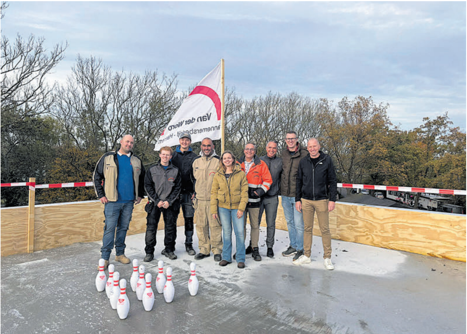
Het team van Bison Bowling op het dak van het pand in aanbouw. Foto: Bison Bowling
