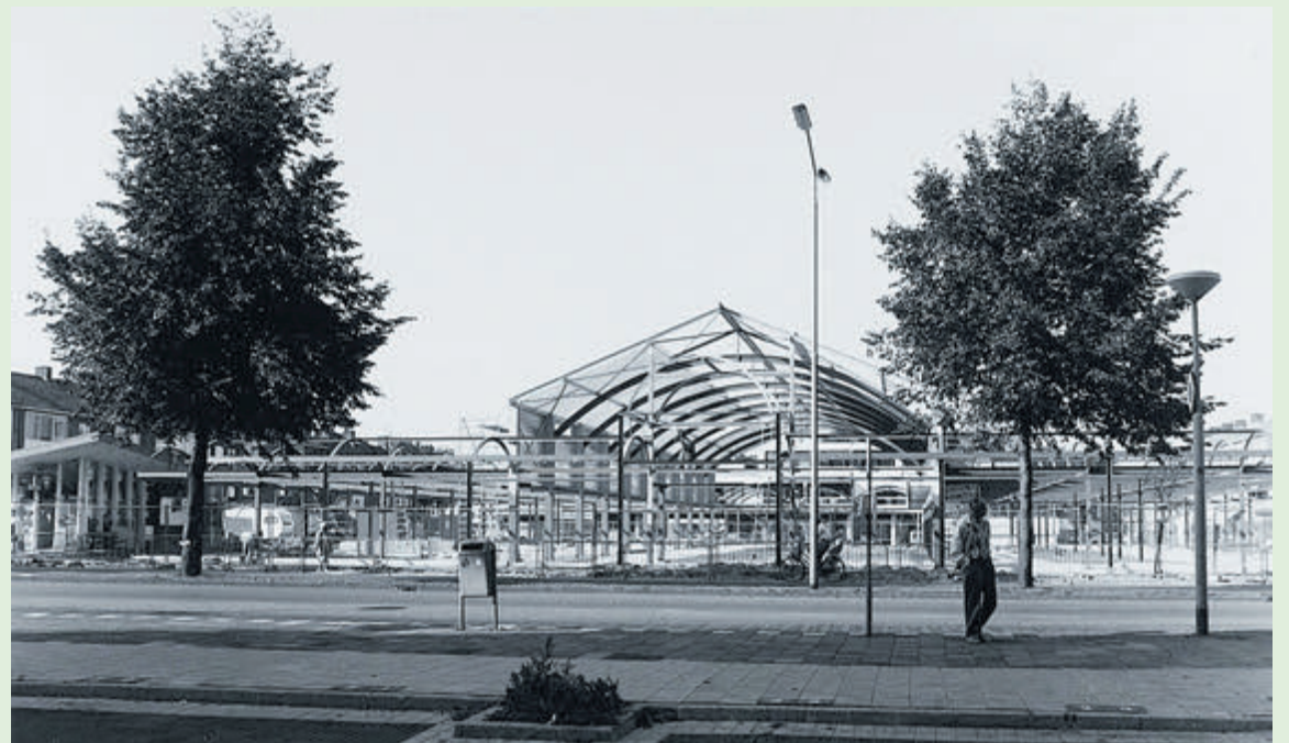
Bouw van winkelcentrum Velsershof op het Marktpllein, gezien in noordelijke richting vanaf de parkeerplaats voor het postkantoor, september 1989. Foto: Noord-Hollands Archief / Beeldcollectie van de gemeente Velsen, inv.no. 14301.
