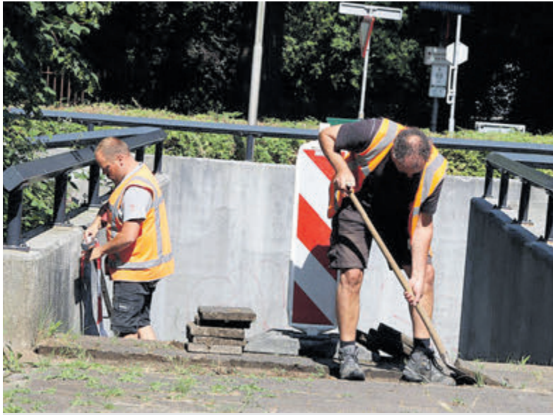
Medewerkers van een serviceteam van de gemeente Velsen bezig met een herstelwerkzaamheden bij het fietstunneltje nabij park Velsersbeek.
