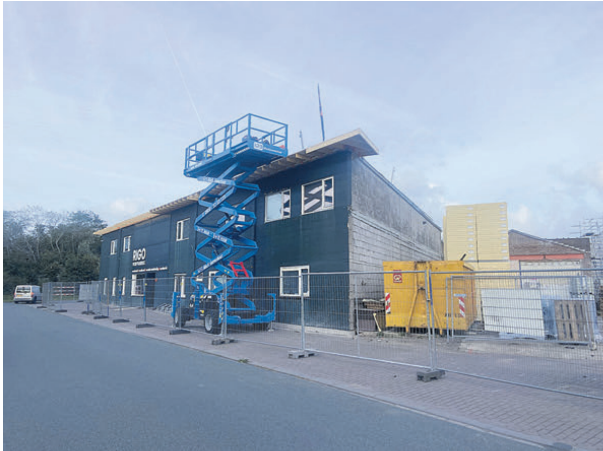
Deze verbouwing is niet alleen om te verfraaien, maar natuurlijk ook om te verduurzamen. Foto: aangeleverd
