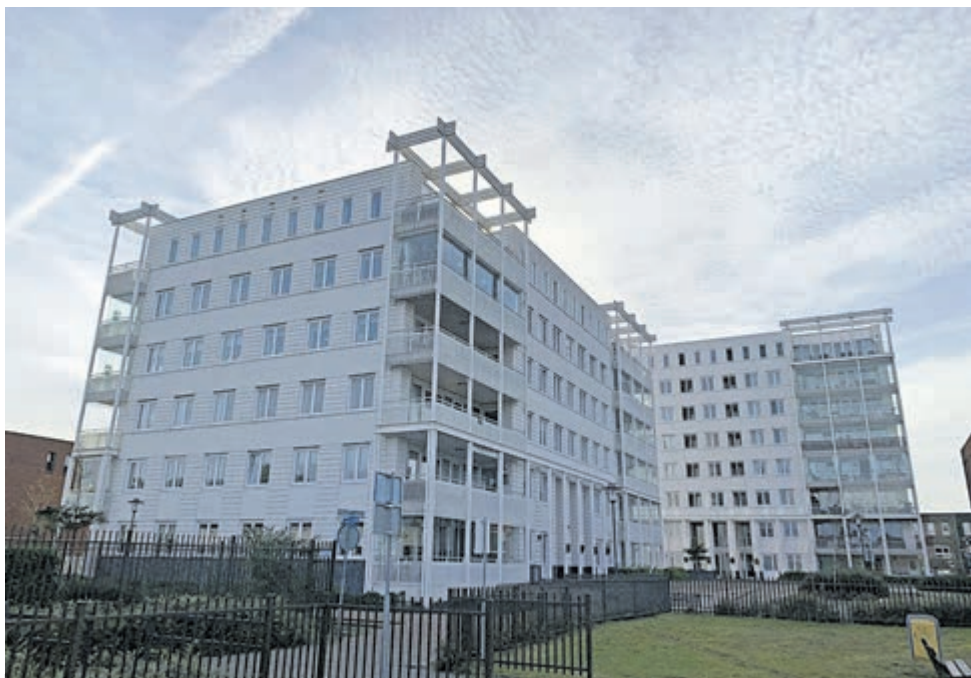
Op de daken van de gebouwen Hoogtij en Laagtij kunnen ongeveer 280 zonnepanelen gelegd worden. Foto: aangeleverd
