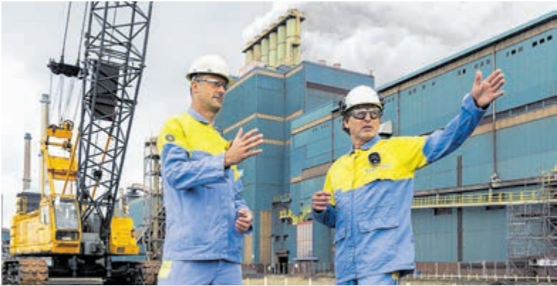
Mark v.d Berg en Vincent Waanders bij de gestart met de bouw van de ontstoffings- en DeNOx-installatie bij de Pelletfabriek. Foto: aangeleverd
