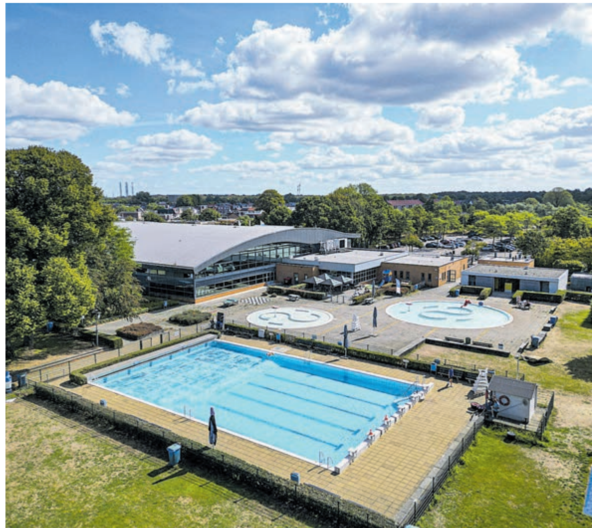
Gedurende de werkzaamheden blijft het zwembad geopend. Foto: aangeleverd SRO Velsen
