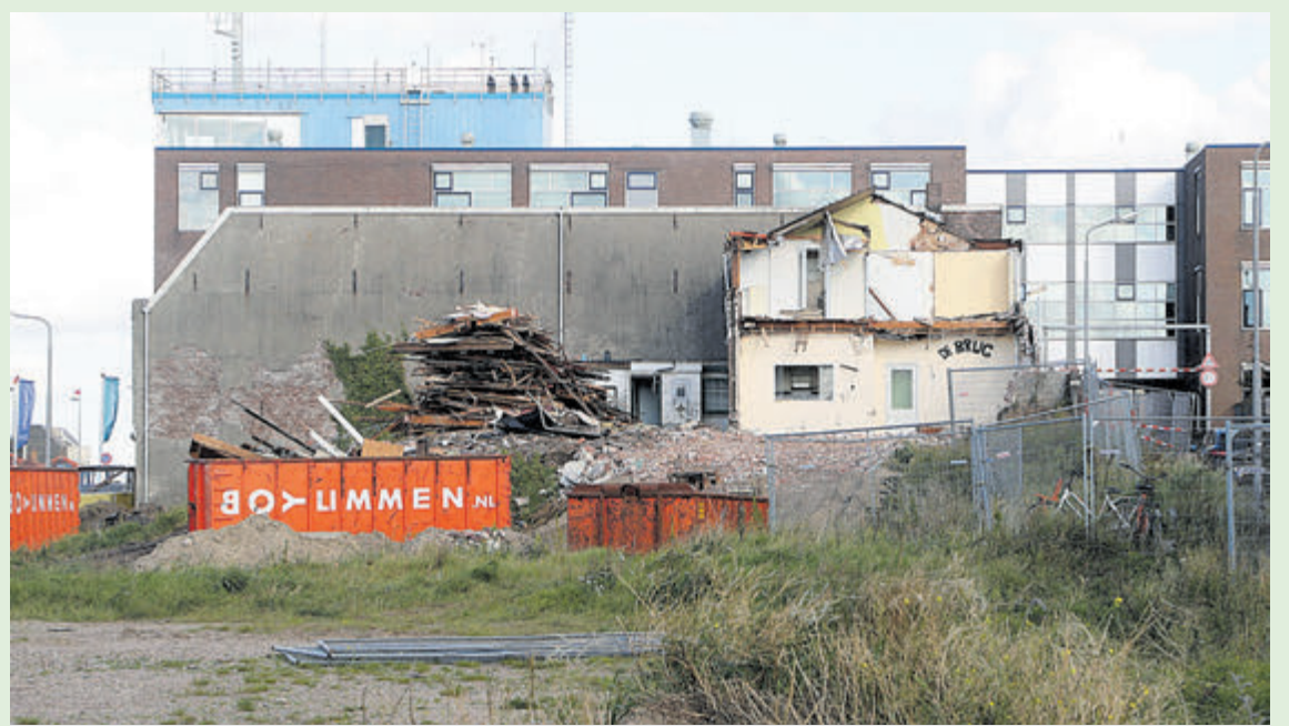
Blik op de sloop van de woningen, met de muurtekst 'De Brug' op een binnenmuur van een van de woningen. Foto: Erik Baalbergen
