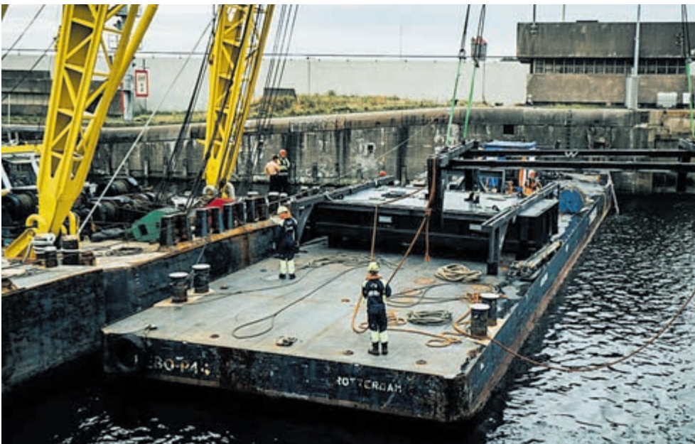
De binnendeur van de Noordersluis in IJmuiden is afgelopen week vervangen. Foto aangeleverd: Spie/Rijkswaterstaat
