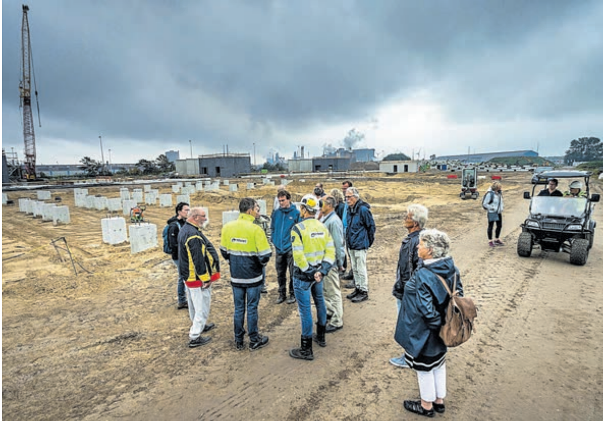
Het terrein langs de Zeestraat waar TenneT een transformatorstation bouwt. Foto: aangeleverd
