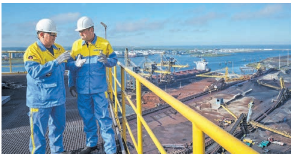
Via een nieuwe buitenkade worden grote onderdelen van het Groen Staal Project aangevoerd.
