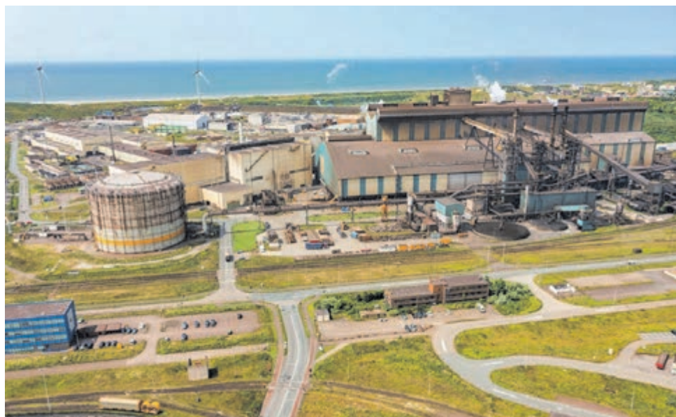
Om ruimte te maken voor de nieuwe installaties, is het de bedoeling om de gashouder naast de Staalfabriek af te breken. Verderop op het terrein herrijst een nieuwe.
