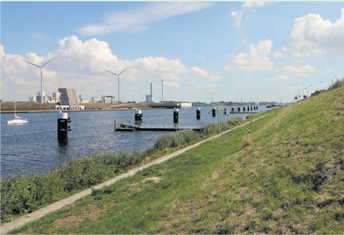
Het bestaande en inmiddels begaanbaar gemaakte oude pad onderlangs de Kanaaldijk, gezien naar het westen. Bij de hijskraan en rechts daarvan wordt nog volop gewerkt aan nieuwe wachtplaatsen.
