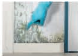
Schimmelplekken door vochtproblemen.
