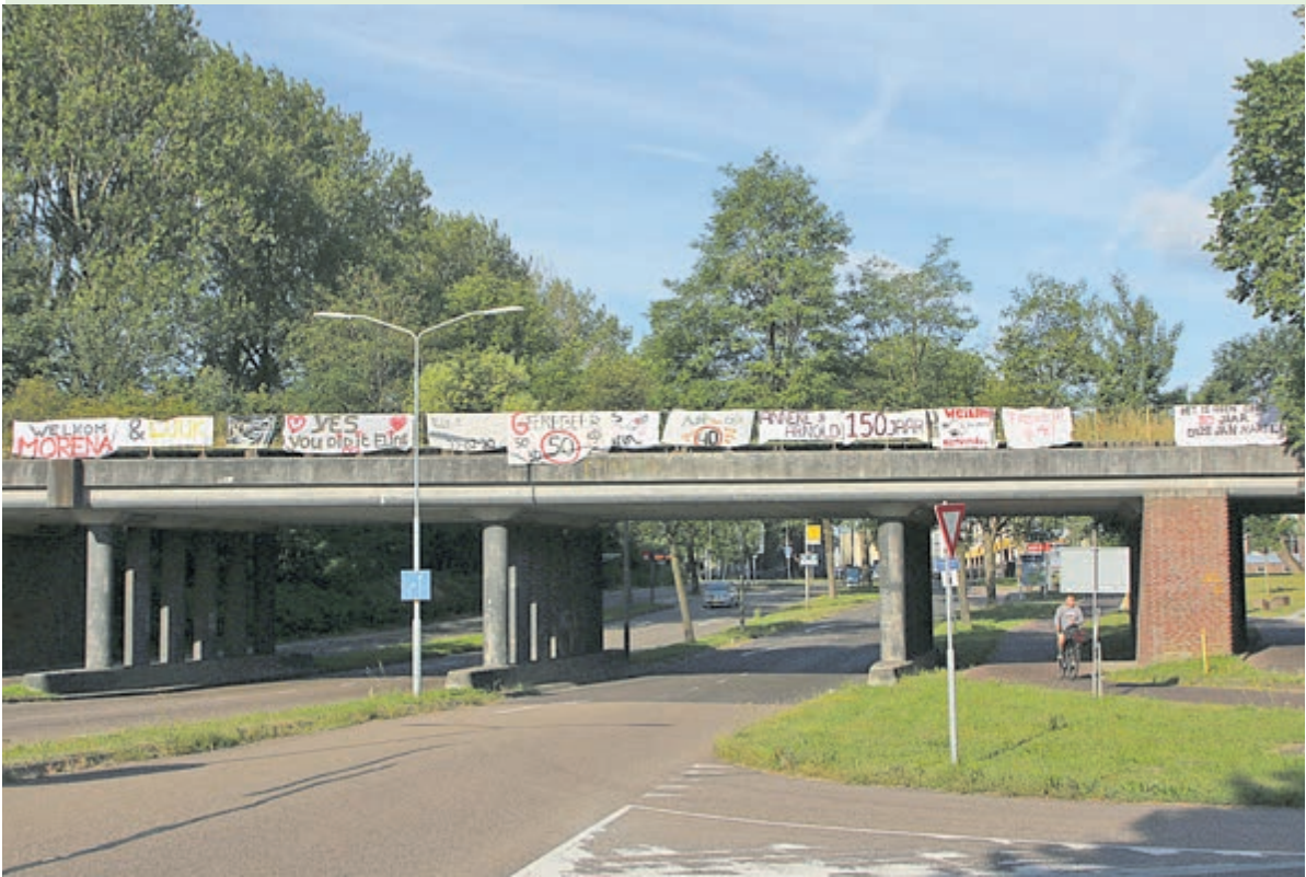
Het bijna volbehangen spoorviaduct, een maandje geleden. Foto: Erik Baalbergen
