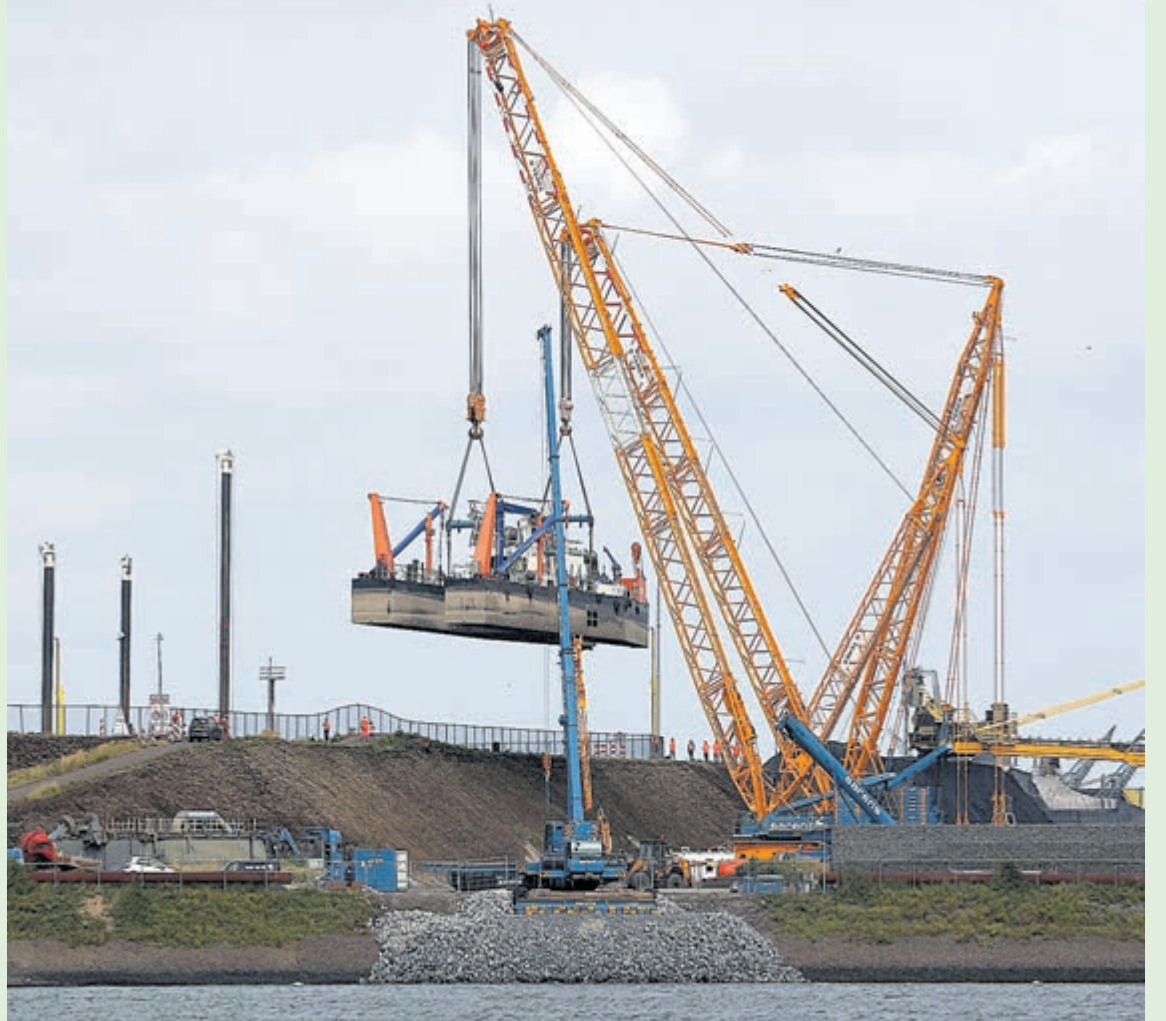
Het grootste deel van de snijkopzuiger Biesbosch wordt over de dam gehesen. De rode "bol" rechtsonder is de snijkop. Foto: Erik Baalbergen
