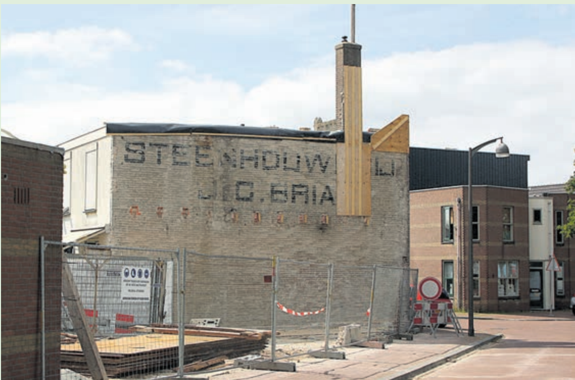
De “nieuwe” geveltekst aan het Koningsplein. Om instorting van de schoorsteen van het woonhuis aan de President Krügerstraat te voorkomen is een houten constructie geplaatst, waarachter een deel van de geveltekst weer verstopt is. Foto: Erik Baalbergen
