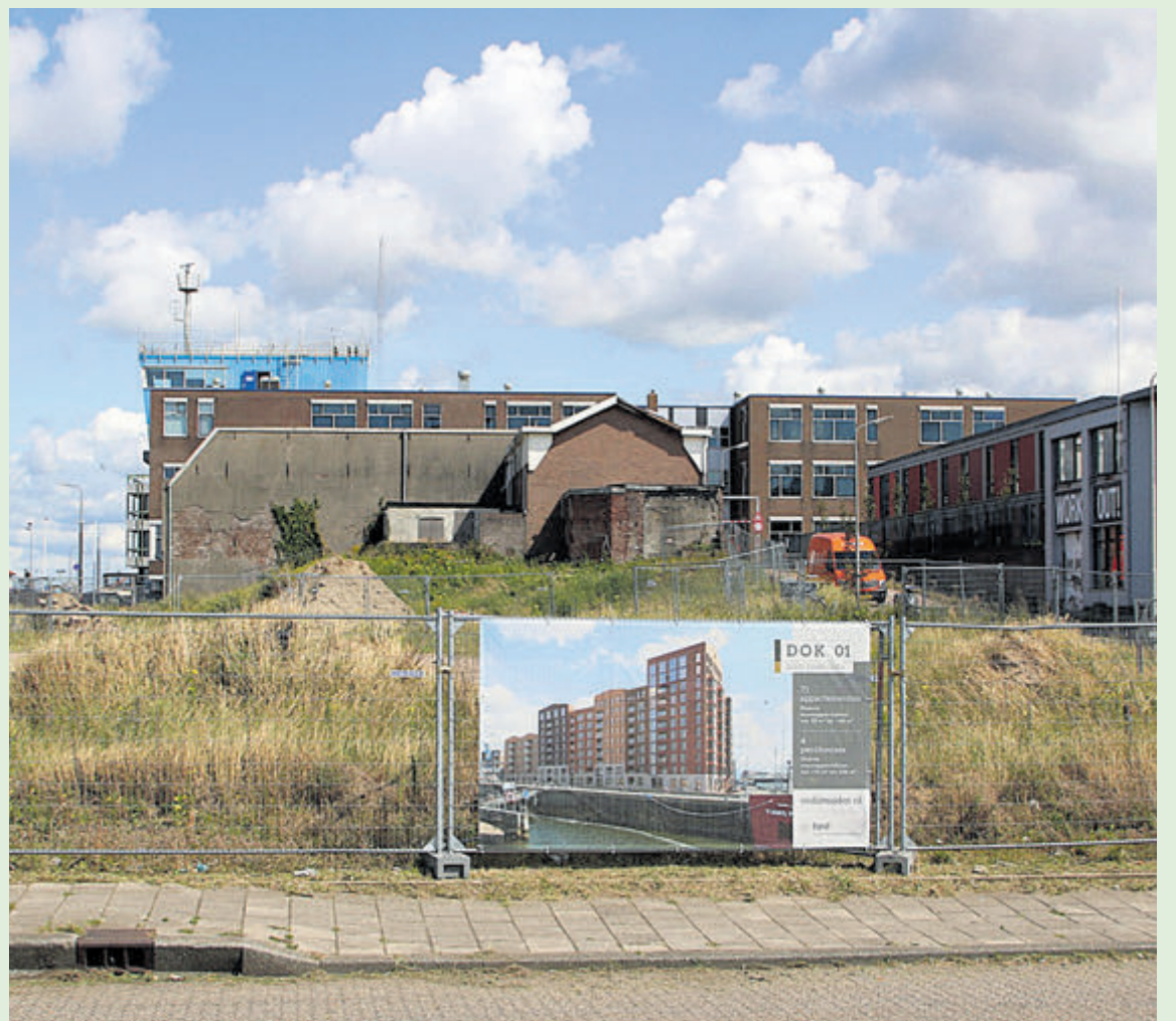
Het al enige tijd afgehekte terrein voor de bouw van DOK 01. Op de voorgrond zien we een fotodoek met een impressie van het complex, gezien vanaf het water. Foto: Erik Baalbergen
