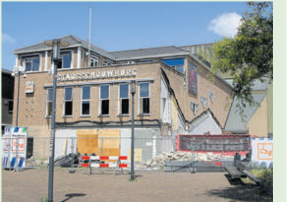
De Stadsschouwburg Velsen in 2025, na de sloop van de aanbouw aan de voorzijde en de rechterzijde. Foto: Erik Baalbergen
