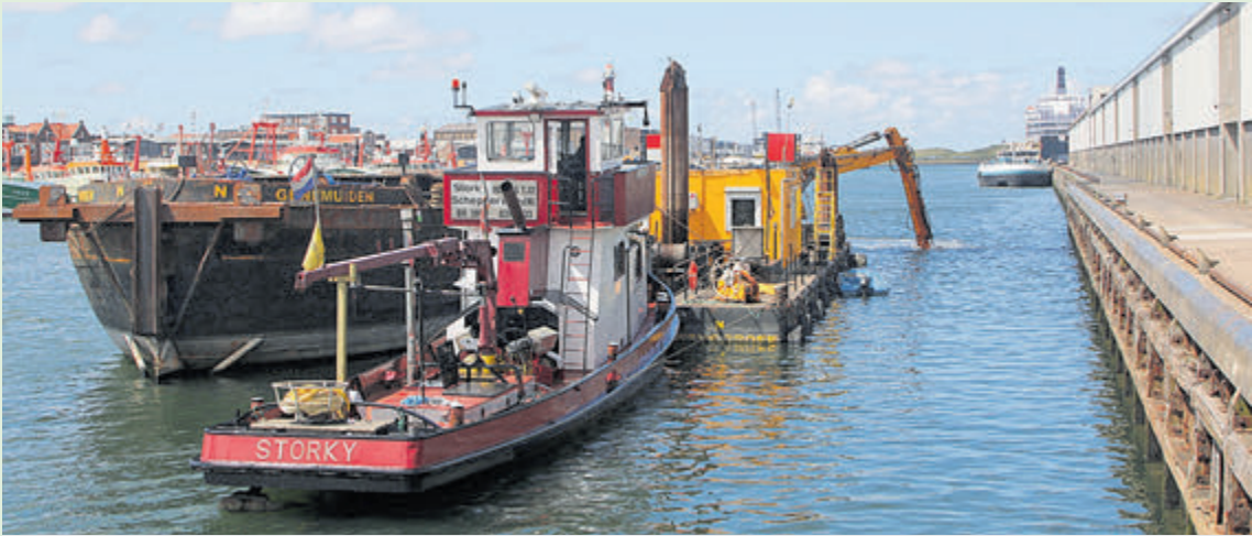
Het verwijderen van grof materiaal van de bodem van de Vissershaven langs de kade. Op de voorgrond ligt de duwboot storky. Links zien we de beunbak en rechts, voor de Storky, het ponton met daarop de graafmachine, die haar grijper net onder water heeft gestoken. Foto: Erik Baalbergen
