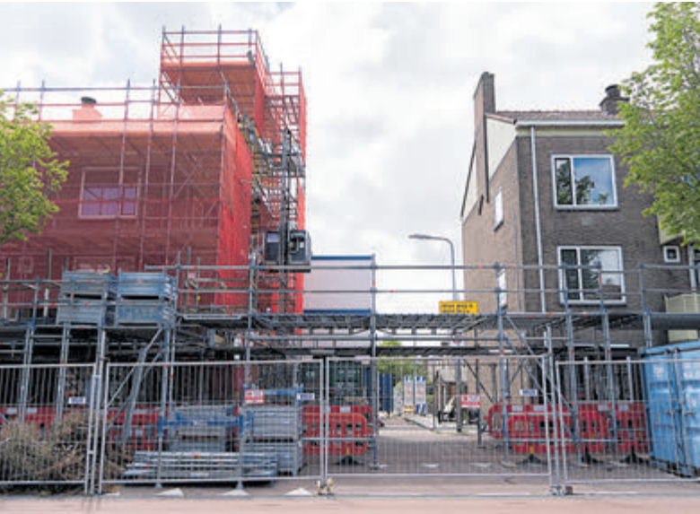
Sinds enkele weken staan een aantal portiekflats in de steigers. Foto: aangeleverd
