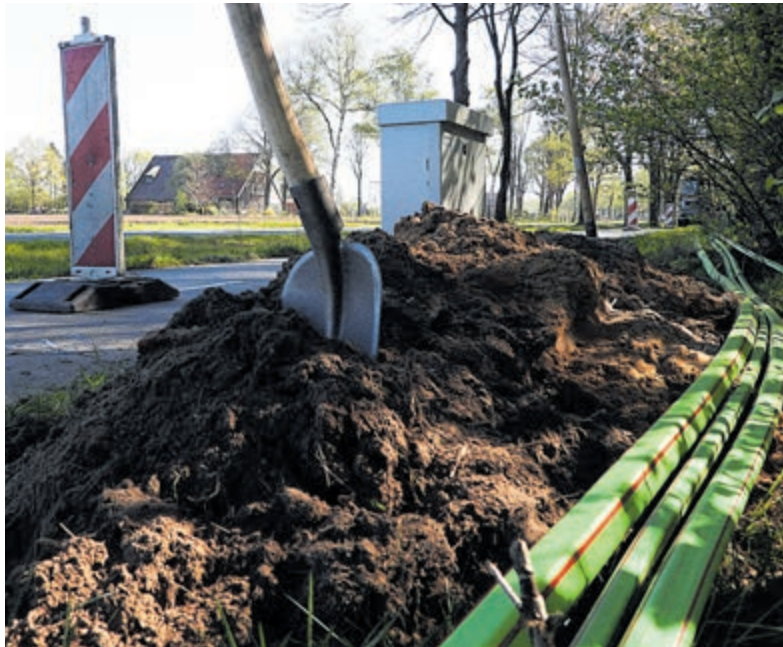
Het aanleggen van het glasvezelnetwerk door DELTA Netwerk. Foto: aangeleverd
