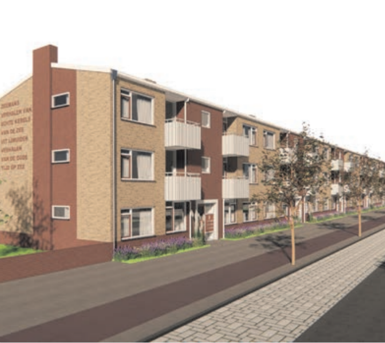
Het energielabel van de portiekwoningen wijzigt van F/G naar A/B. Beeld: Woningbedrijf Velsen
