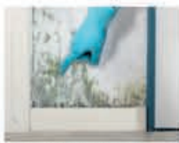
Schimmelplekken door vochtproblemen.
