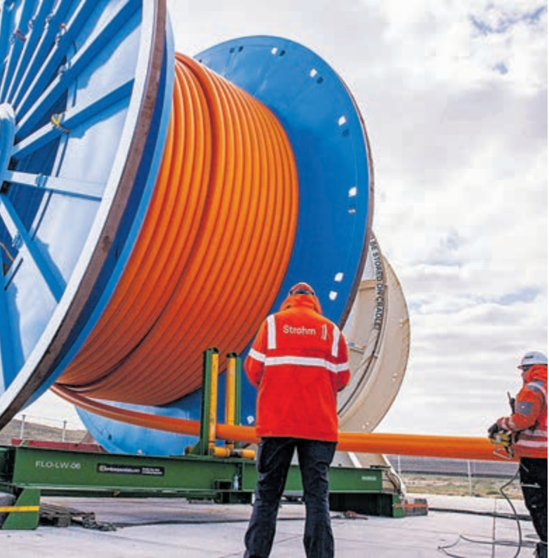
De TCP-leidingen worden getransporteerd op een of meerdere haspels en geïnstalleerd met behulp van kleine schepen of onderzeese pallets, hetgeen zorgt voor een lagere CO2-uitstoot. Foto: aangeleverd
