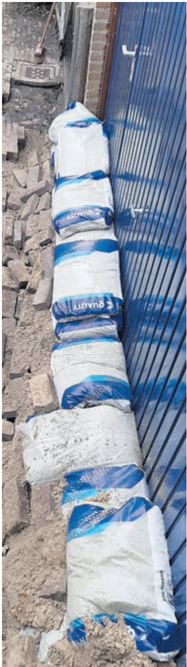
De bewoners hebben inmiddels zandzakken voor het pand gelegd om herhaling te voorkomen.
