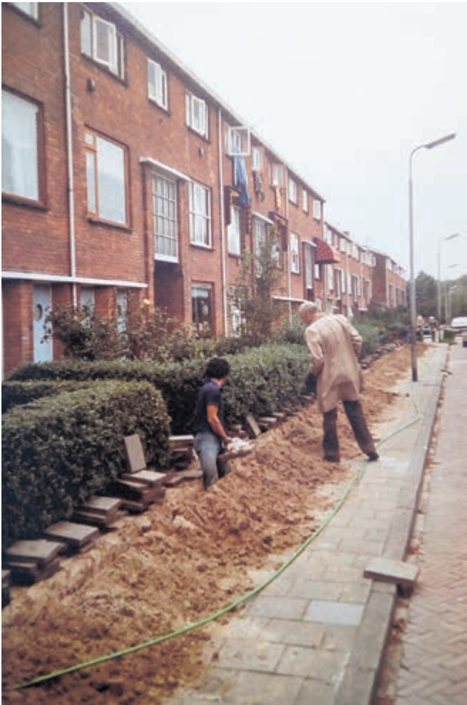
Het vele graafwerk
