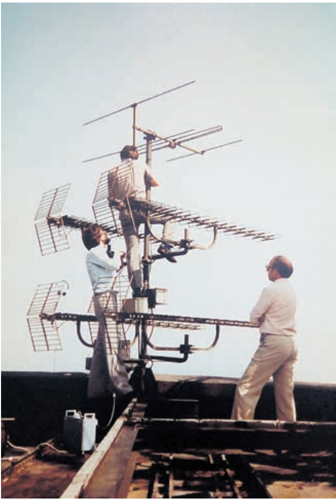
Werkzaamheden aan de antennes op het ontvangststation
