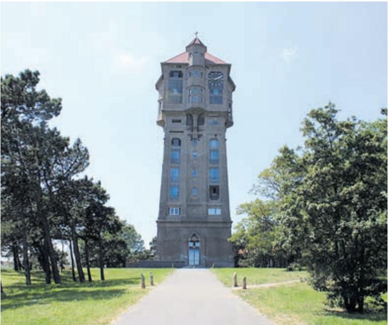
Nummer 2: zicht op de watertoren. Fotograaf: Yelina Hurkmans
