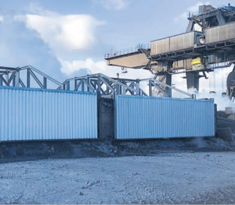
De nieuwe slakkenputten zijn voorzien van mobiele kappen waardoor de stofoverlast door de verwerking van converterslak door Harsco naar verwachting verder zal afnemen. Foto: aangeleverd
