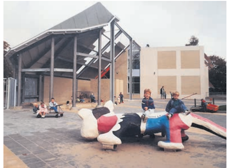
Ook kleuterschool De Boskabouter werd door Hillen & Roosen gebouwd. Foto: Bedrijfsmuseum Hillen & Roosen
