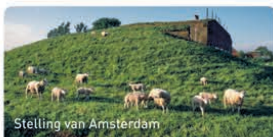
Tankversperring bij Fort Everdingen
