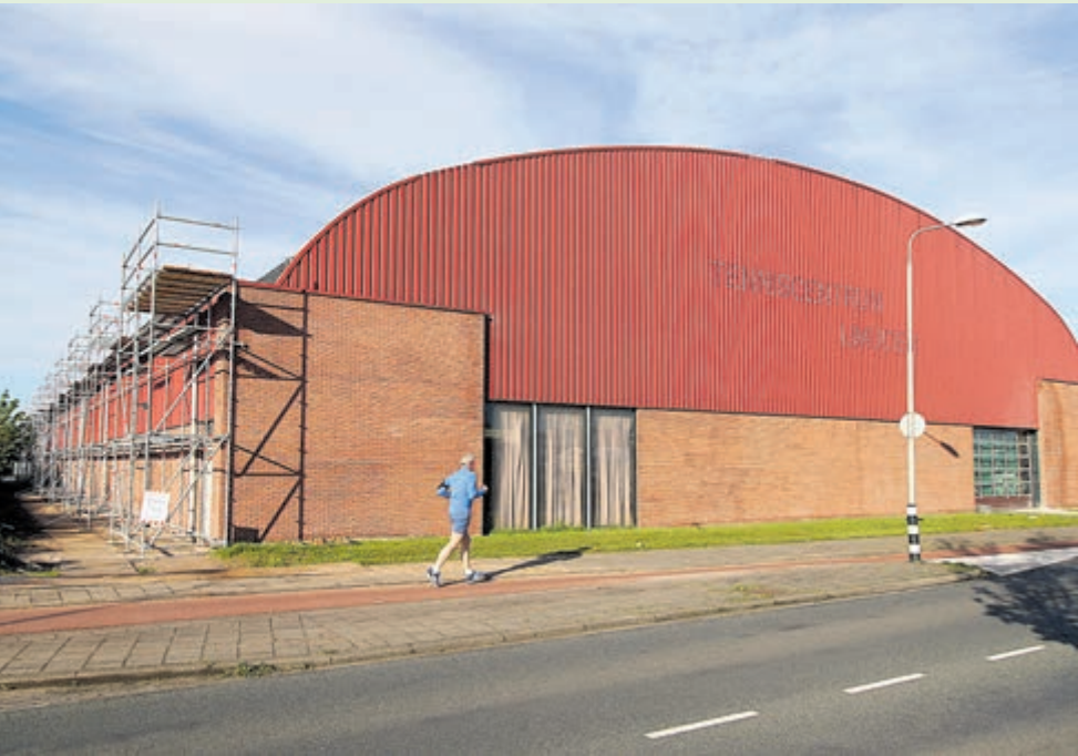
De tennishal aan de Dokweg, gezien vanaf de Raafstraat. De voormalige naam 'Tenniscentrum IJmuiden' is nog vaag zichtbaar op de gevel. De hal staat deze weken letterlijk in de steigers. Foto: Erik Baalbergen
