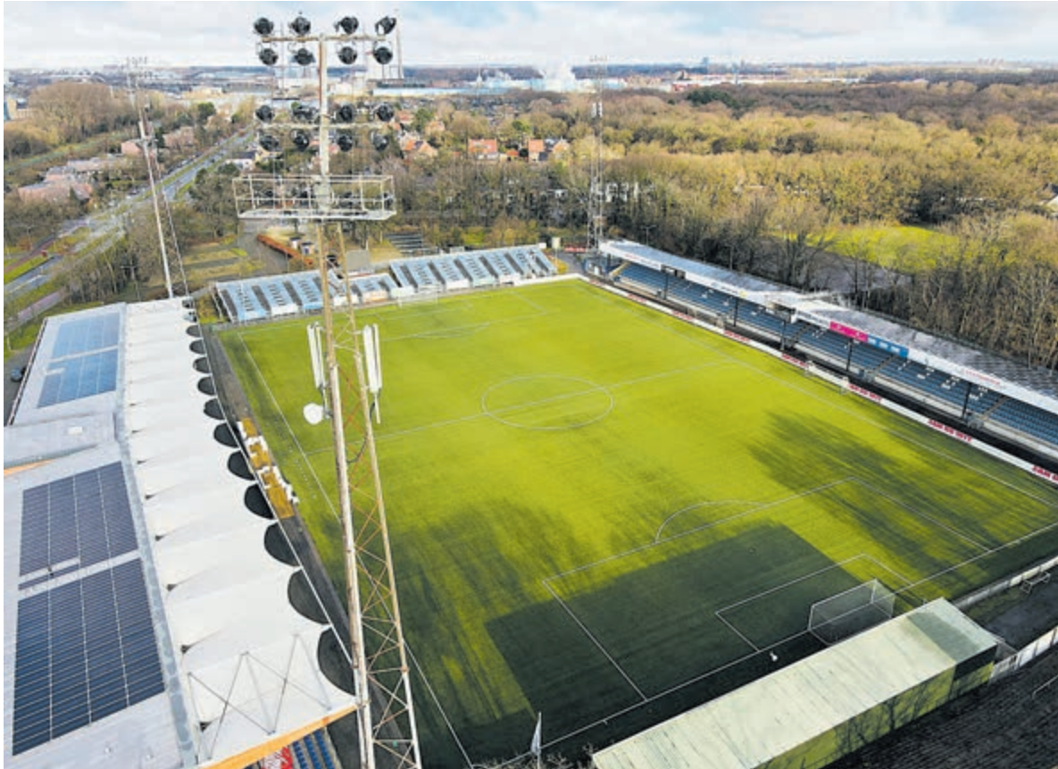
Naast de aanleg van zonnepanelen heeft het stadion nu ook laadpalen voor elektrische auto's. Foto's: aangeleverd
