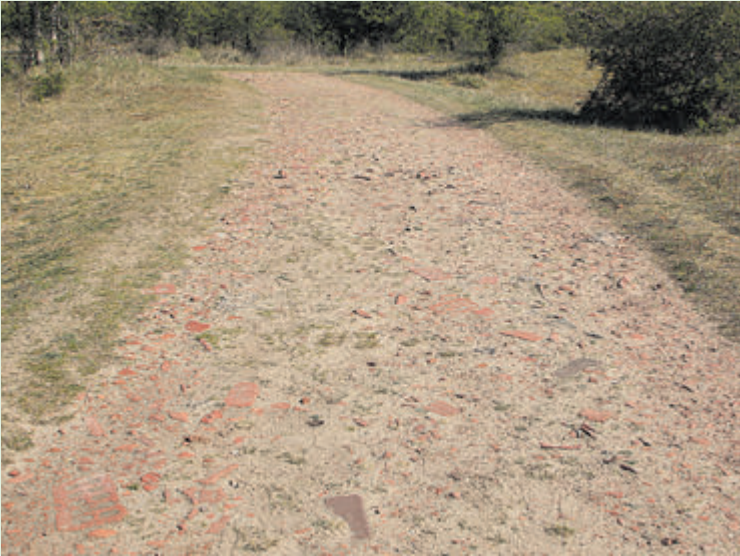
Blik op een met puin geplaveide stuk van het Verbindingspad in het Midden-Herenduin. De radiale bakstenen zijn her en der duidelijk te herkennen. Foto: Erik Baalbergen 2025
