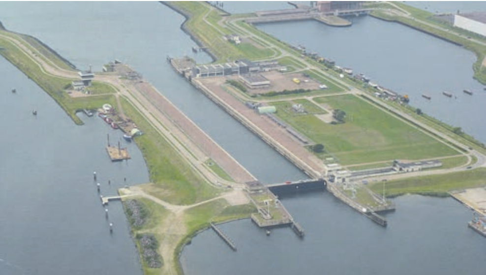
De foto uit 2011 toont de Noordersluis ruim voor aanvang van de bouw van de nieuwe zeesluis.
