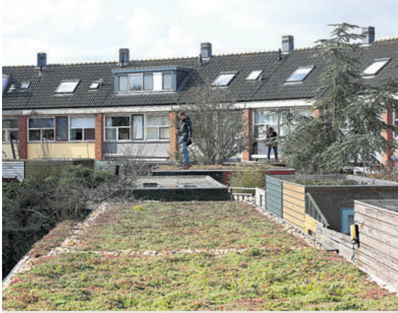
Groen dak met sedum zoals het in de Santhaesbuurt aangelegd gaan worden. Foto: aangeleverd
