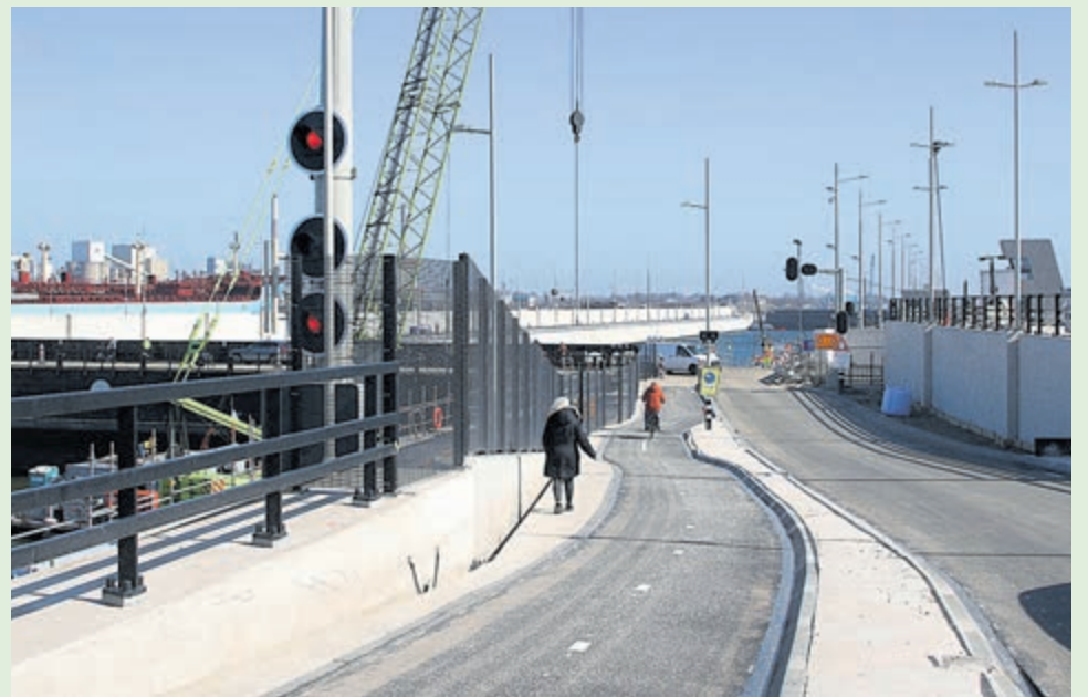
De Zeesluis IJmuiden in z'n volle lengte, gezien vanaf de weg vanaf de Middensluis, vanaf bovenaan de helling naar de buitendeur van de nieuwe sluis. Links zien we de buitendeur, rechts van het midden de binnendeur. Foto: Erik Baalbergen
