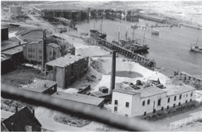
De IJmuidense haven na het bombardement (foto: aangeleverd)
