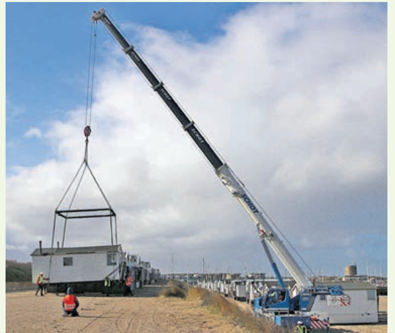
Fotobijlschrift: Het plaatsen van een van de strandhuisjes op de bovenste rij van het kleine strand. Foto: Erik Baalbergen, 2026
