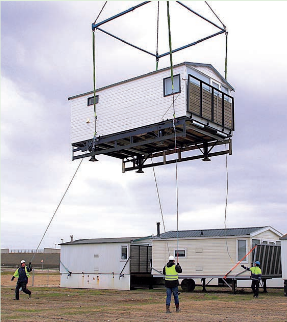
Met grote precisie wordt elk huisje vanaf de winterstalling bij het kleine strand opgehesen om vervolgens op een oplegger te worden geplaatst. Foto: Erik Baalbergen
