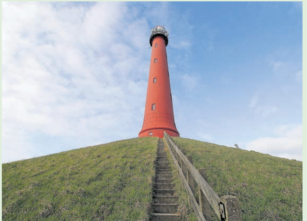
De rijksmonumentale binnenvuurtoren op de gemeentelijk monumentale terp. Foto: Erik Baalbergen
