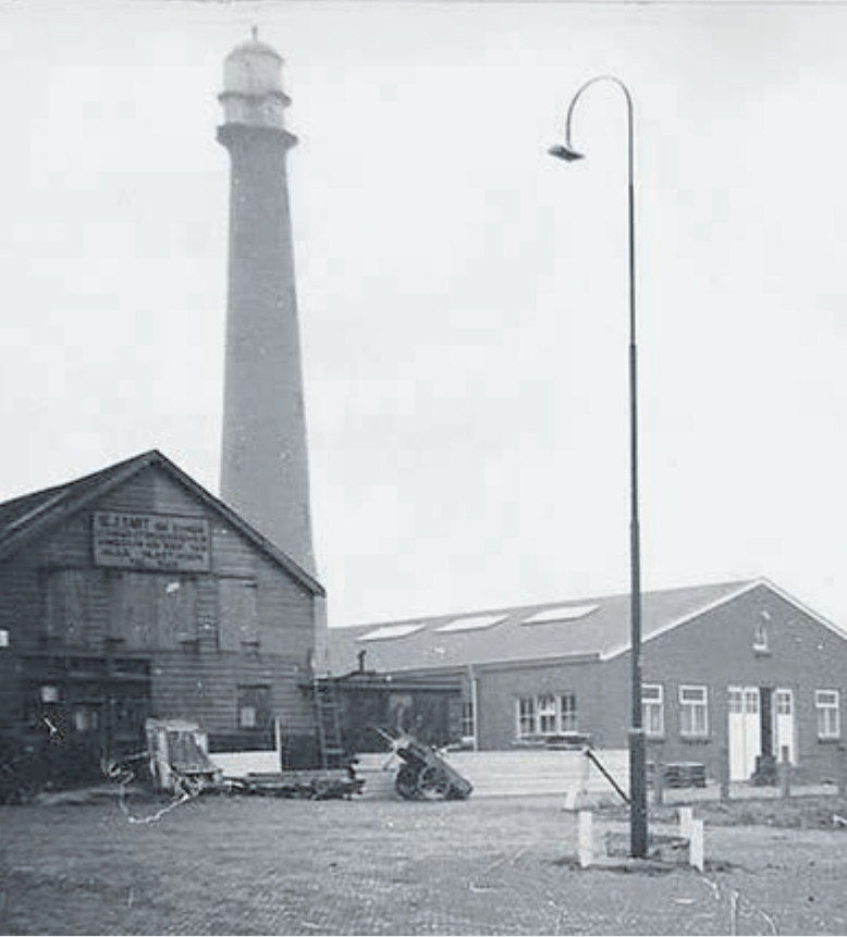
Een archieffoto van het oude bedrijfspand in IJmuiden, vlakbij de vuurtoren. Foto: aangeleverd
