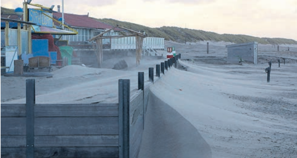
Even lekker op het terras zitten? Eerst moet er heel wat zand verwijderd worden. De harde wind zorgde ervoor dat zich zandduinen vormden tegen (en op) de terrassen. Foto: Erik Baalbergen
