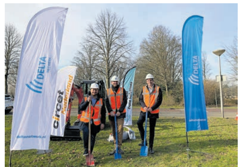
Wethouder Sander Smeets, samen met de directie van DELTA netwerk en aannemer Circet Nederland, hebben de eerste schop in de grond gezet. Foto: aangeleverd
