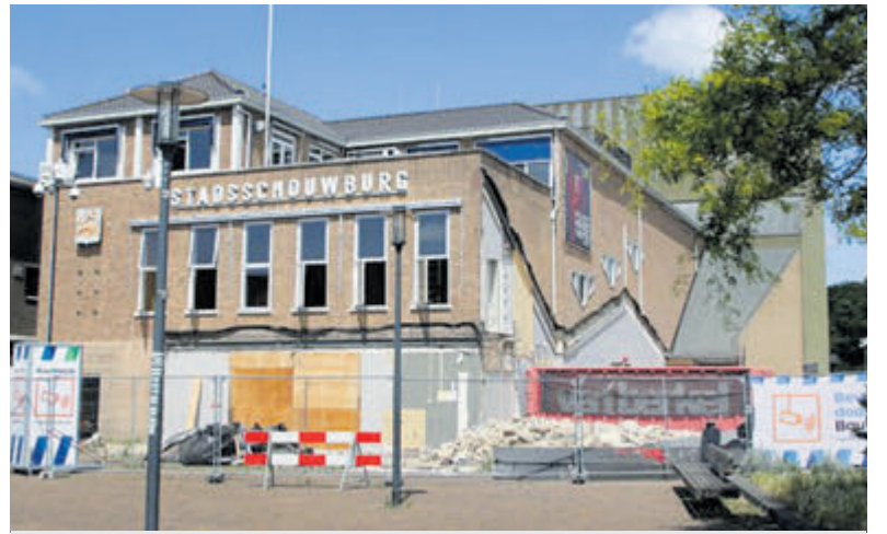
De Stadsschouwburg Velsen in 2025, na de sloop van de aanbouw aan de voorzijde en de rechterzijde. Foto: Erik Baalbergen
