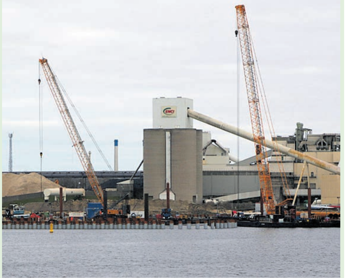
Blik vanaf de voormalige treinhalte Casembroodstraat op de werkzaamheden van de aanleg van de damwand aan de noordoever van het Binnenspuikanaal. Foto: Erik Baalbergen
