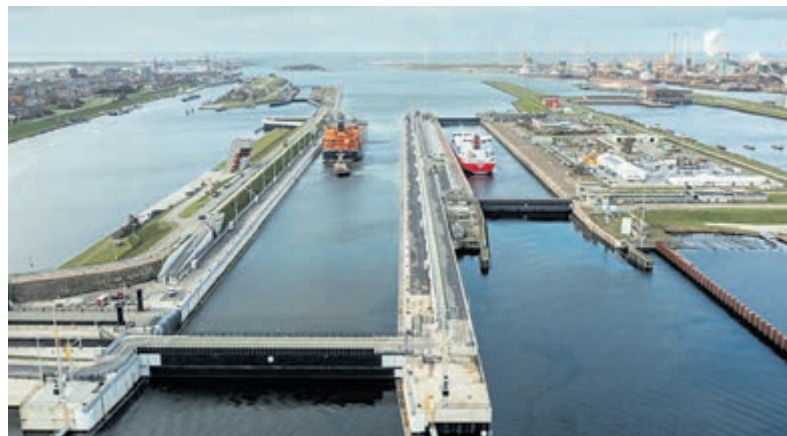
Groot onderhoud Noordersluis. Foto: aangeleverd Rijkswaterstaat
