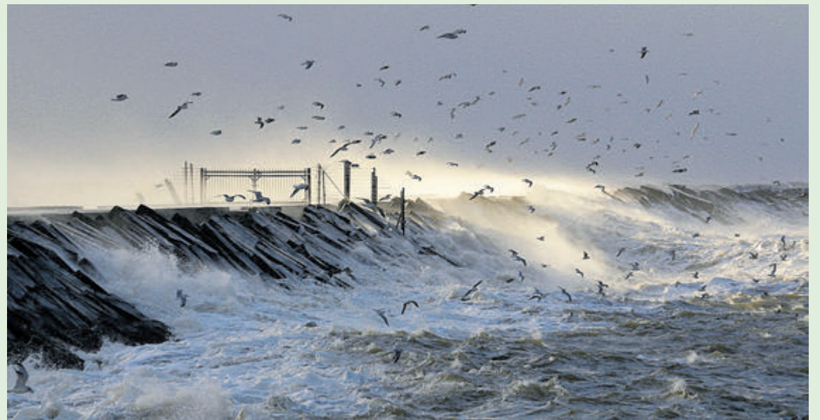
Overslaande golven rond het afgesloten hek op de Zuidpier. Foto: Erik Baalbergen
