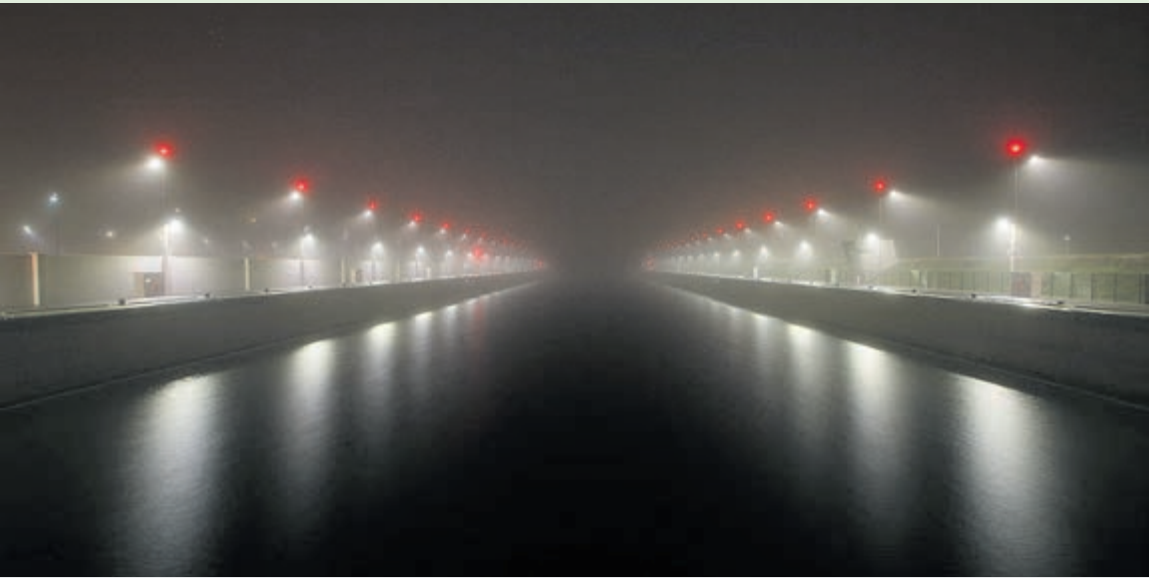
De Zeesluis IJmuiden lag er zaterdagmorgen verlaten, mistigjes en gladjes bij. Het wateroppervlak is in elk geval al opgepoetst voor de opening! Foto: Erik Baalbergen
