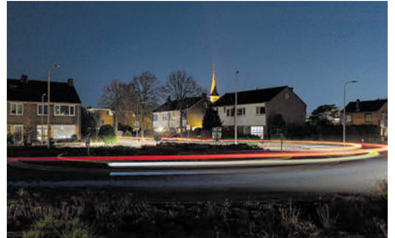
De straatverlichting langs de Van den Vondellaan is defect vanaf het spoorviaduct tot aan het eerste woonblok na de rotonde. Foto: Inter Visual Studio / Koen de Boer
